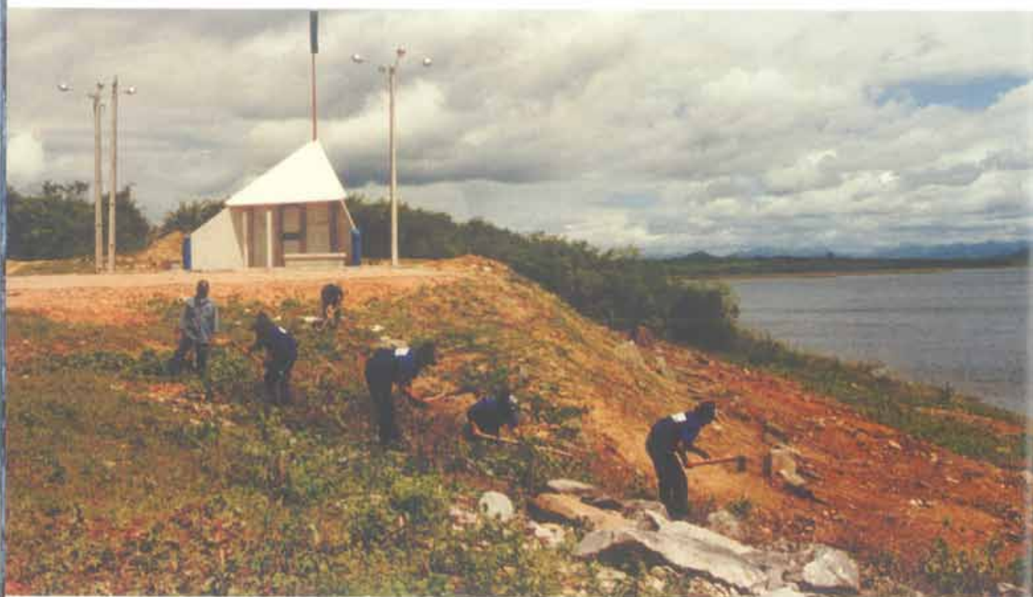
Posto de Fiscalização e Manutenção do Açude Riachão - Pacatuba
