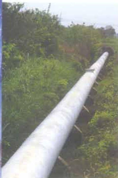
Adutora Iló Acarape
